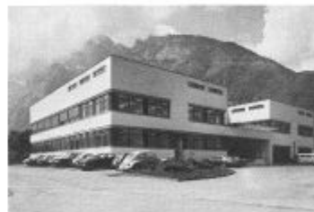
Zur Entlastung des Stammwerkes, Baugruppenfertigung im Zweigwerk Mollis.
