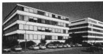
Das erste Fabrikgebäude in Regensdorf, wobei der Gebäudeteil rechts im Bild erst 1968 dazukam.
