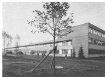
Das neueste Fabrikgebäude im benachbarten Ausland, Löffingen (Schwarzwald).
