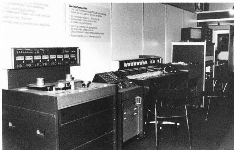
Ansicht C: Auch altbewährt Gutes wurde gezeigt: A800 8-Kanal 1", TLS 2000, Regiepulst 369 und diverse TLS gesteuerte Videomaschinen.
