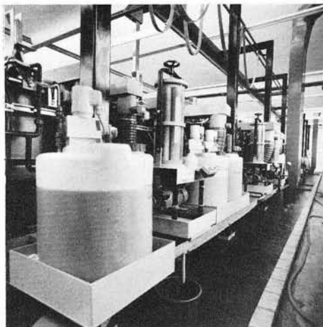
11. Alle Hilfseinrichtungen wie Chemikalienpumpen, Filter, Zuluft- und Abluftkanäle sind auf der Rückseite des Leiterplattenautomaten angeordnet.
