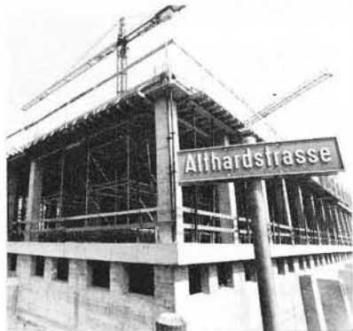
Unser Neubau an der Althardstrasse Nr. 10 in Regensdorf.
